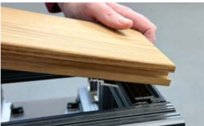
Deckbelag mit montiertem Z-Profil an das entsprechende Profil der Unterkonstruktion anlegen und ausrichten.
