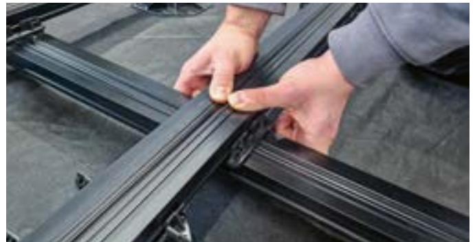
TWIXT Kreuzverbinder unten (ab 71 mm) auf die ausgerichtete Konterlattung einklicken. Aluminium-Unterkonstruktion auf TWIXT Kreuzverbinder unten (ab 71 mm) aufklicken.
