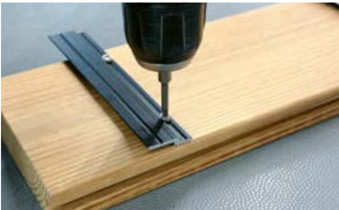
Z-Profil an der Deckbelag-Unterseite ausrichten und verschrauben.
