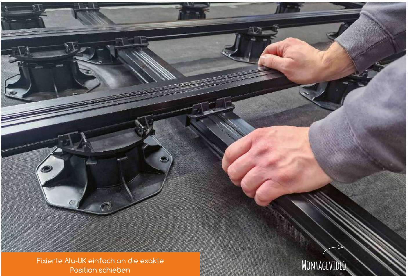
KL-Kreuzverbinder auf die ausgerichtete Konterlattung einklicken
