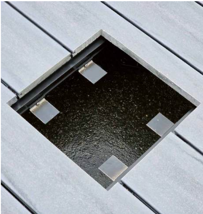
Windlastträger an der Alu-UK befestigen
