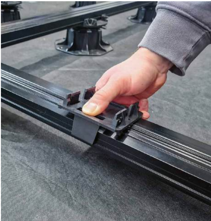
KL-Kreuzverbinder auf die ausgerichtete Konterlattung einklicken
