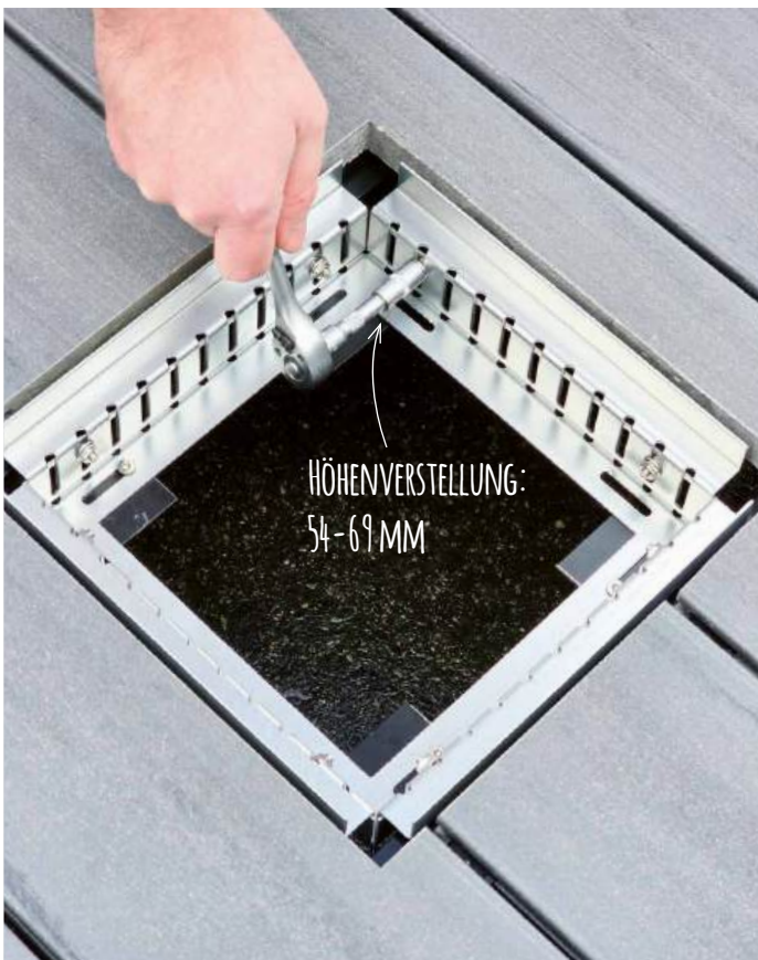
Höhe des Revisionskastens an den Terrassenbelag anpassen
