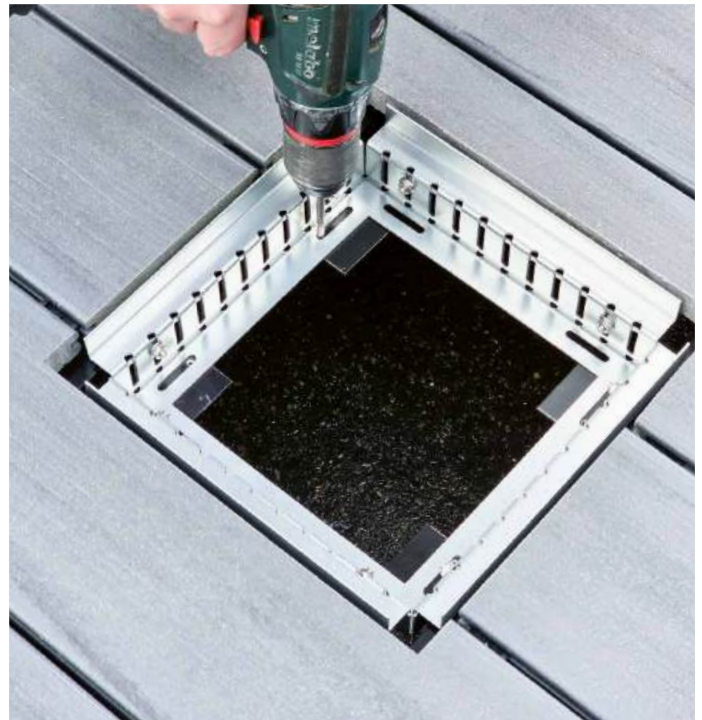
Revisionskasten einsetzen und an Windlastträger verschrauben
