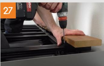
Nach dem Ausrichten der Dielen wird der Clipper mit der Bohrschraube 3,9x19 mm auf der Unterkonstruktion verschraubt.
