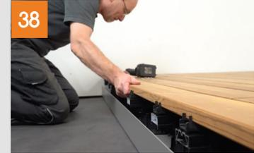
Für einen maßgenauen Abschluss der Terrasse wird die letzte Dielen vor dem Einbau auf die passende Breite geschnitten und die Hilfslinien für die Montage des Clippers auf der Rückseite angezeichnet. Danach den Clipper nach dem beschriebenen Prinzip fixieren.
