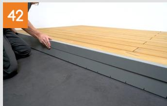
Das Oberteil der Seitenverblendung an einem Ende des Unterteils beginnend aufstecken. Das gleiche Prinzip wird bei den weiteren Seitenverkleidungen angewandt.
