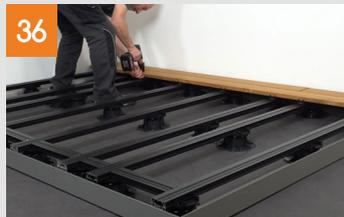
Nun werden die montierten Clipper der zweiten Dielenreihe in die Aufnahme der Clipper der ersten Dielenreihe eingesteckt. Nach dem Ausrichten der Dielen wird der Clipper mit der Bohrschraube 3,9x19 mm jeweils auf der Unterkonstruktion verschraubt. Nach dem gleichen Prinzip werden auch die weiteren Dielen in der Fläche verlegt.
