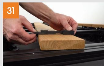
Anschließend den Clipper an der markierten Stelle anlegen und den hinteren Teil des Clippers mit der passenden Holzschraube verschrauben. Nun den Clipper bis zum Anschlag zusammenschieben und auch den vorderen Teil des Clippers mit der zweiten Holzschraube fixieren.
