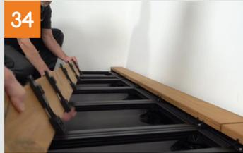
Nach dem gleichen Prinzip werden die weiteren Clipper auf der Rückseite der Dielen verschraubt und diese anschließend mit der Sichtseite nach oben gedreht.
