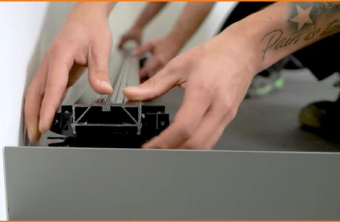
Seitenverblendung und Terrassenlager auslegen und Schienen einklicken
