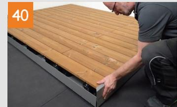
Nach dem Aufschrauben des Clippers und dem Ausrichten der letzten Dielenreihe wird der Clipper mit der Bohrschraube 3,9x19 mm auf der Unterkonstruktion verschraubt.
