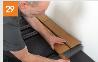
Die Terrassendiele der zweiten Reihe mit der Sichtseite nach unten gegen die Clipper der ersten Reihe auf die Unterkonstruktion legen, ausrichten und auf der Rückseite mit Hilfslinien versehen.
