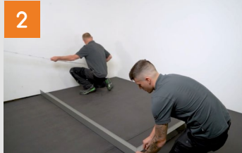
Seitenverblendung und Terrassenlager auslegen und Schienen einklicken
