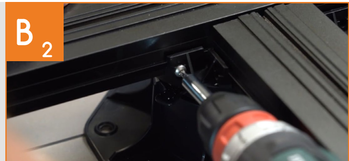
Unterkonstruktion ausrichten und mit Lagern verschrauben
