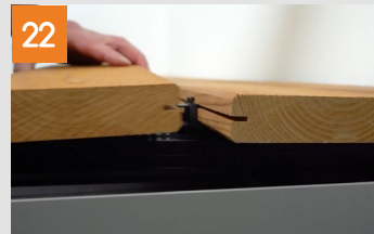
Verlegung der Dielen in der Fläche
