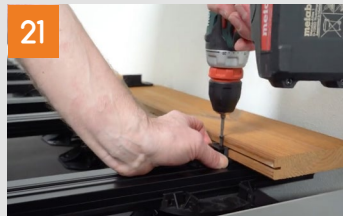
Verlegung der Dielen in der Fläche
