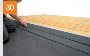
Fertigstellung der Seitenverblendung
