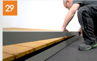
Fertigstellung der Seitenverblendung
